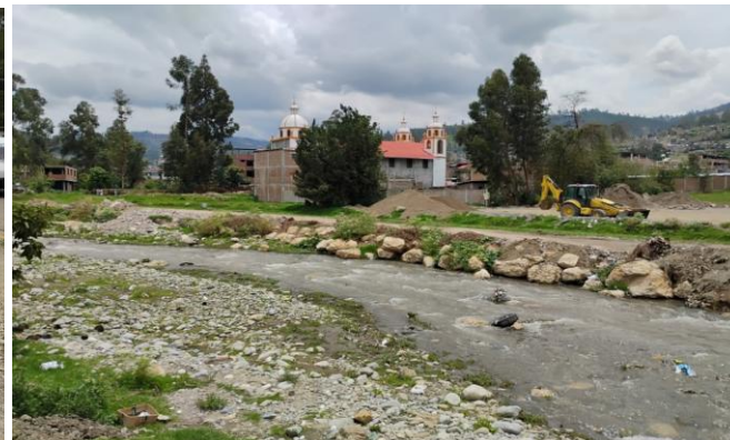
IMAGEN 04: SE OBSERVA EL CAUCE SIN MANTENIMIENTO Y EL NIVEL PELIGRO QUE PRESENTA ANTE MAXIMAS AVENIDAS ASI COMO EL MATERIAL DE DESMONTE ACUMULADO EN LA MARGEN IZQUIERDA AGUAS ABAJO
