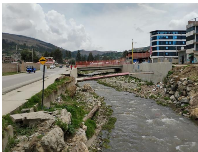
IMAGEN 02: SE MUESTRA QUE EN AMBAS MARGENES SE REQUIERE DE MURO DE CONTENCIÓN Y DESCOLMATACION DEL CAUCE COMO SE MUESTRA A LA ALTURA DEL PUENTE
