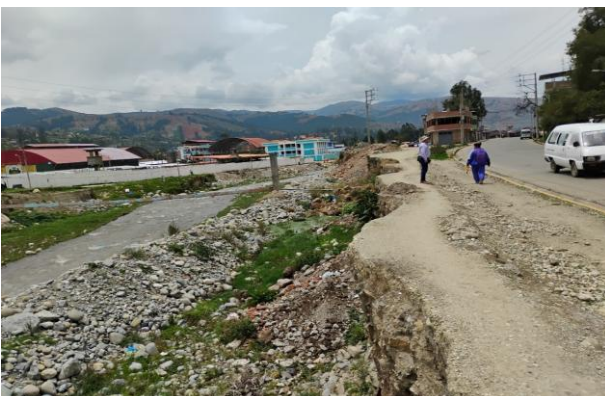
IMAGEN 03: SE MUESTRA EL TALUD EROSIONADO EN AMBAS MARGENES Y REQUIERE CONSTRUCCION DE MURO PARA PROTECCION DE LA TROCHA CARROZABLE Y LA IE ASI COMO LAS VIVIENDAS
